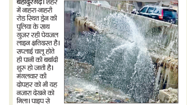
बहादुरगढ़। शहर में नाहरा-नाहरी रोड स्थित ड्रेन की पुलिया के साथ गुजर रही पेयजल लाइन क्षतिग्रस्त है। सप्लाई चालू होते ही पानी की बर्बादी शुरू हो जाती है। मंगलवार की दोपहर को भी यह नजारा देखने को मिला। पाइप से काफी प्रेशर के साथ पानी निकलकर ड्रेन में बह रहा था। राहगीर मोहित ने बताया कि वह बीते चंद दिनों से ऐसी स्थिति देख रहे हैं। दो जगह से पाइप फूटा हुआ है और पानी ड्रेन में जाकर बर्बाद हो रहा है। इस तरह किसी का ध्यान नहीं है। उधर, जनस्वस्थ विभाग अभियंत्रिका विभाग के एसडीई संदीप दहल ने कहा कि मामला उनके संज्ञान में अब आया है। कर्मचारियों को मौके पर भेज दिया गया है। जल्द ही पाइप लाइन की मरम्मत कर दी जाएगी।
